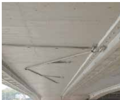
Рисунок 1. Усиление главных балок стационарных пролетных строений. Датчики напряжения на канатах усиления.
