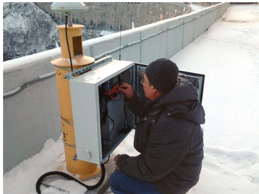
Монтаж мониторингового приемника
