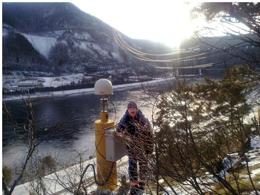
Монтаж базовой станции
